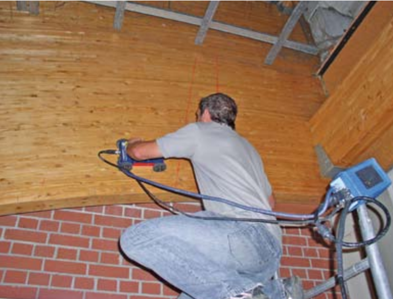
Radar-Messung: Suche nach der Lage von Gewindestangen in BSH-Bindern
