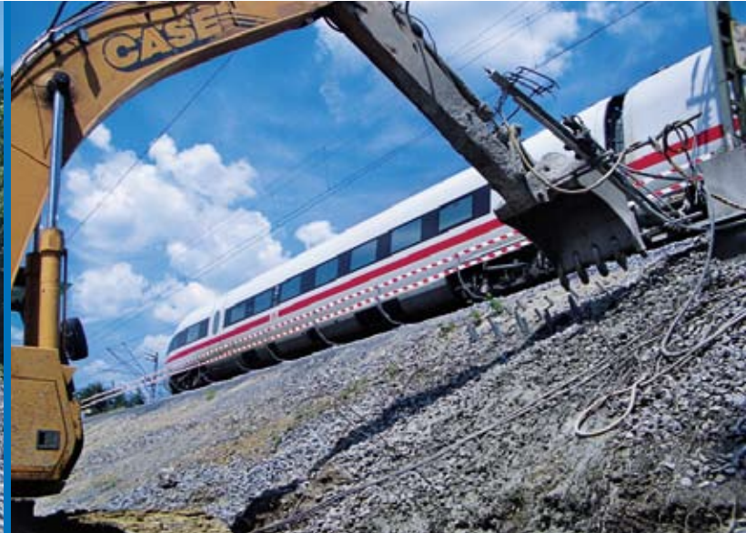
Arbeiten unter laufendem Betrieb
