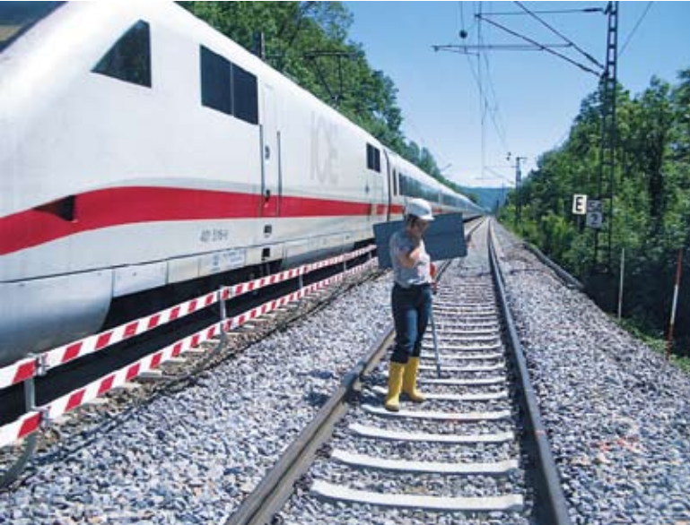
Überwachung der Sanierung hautnah
