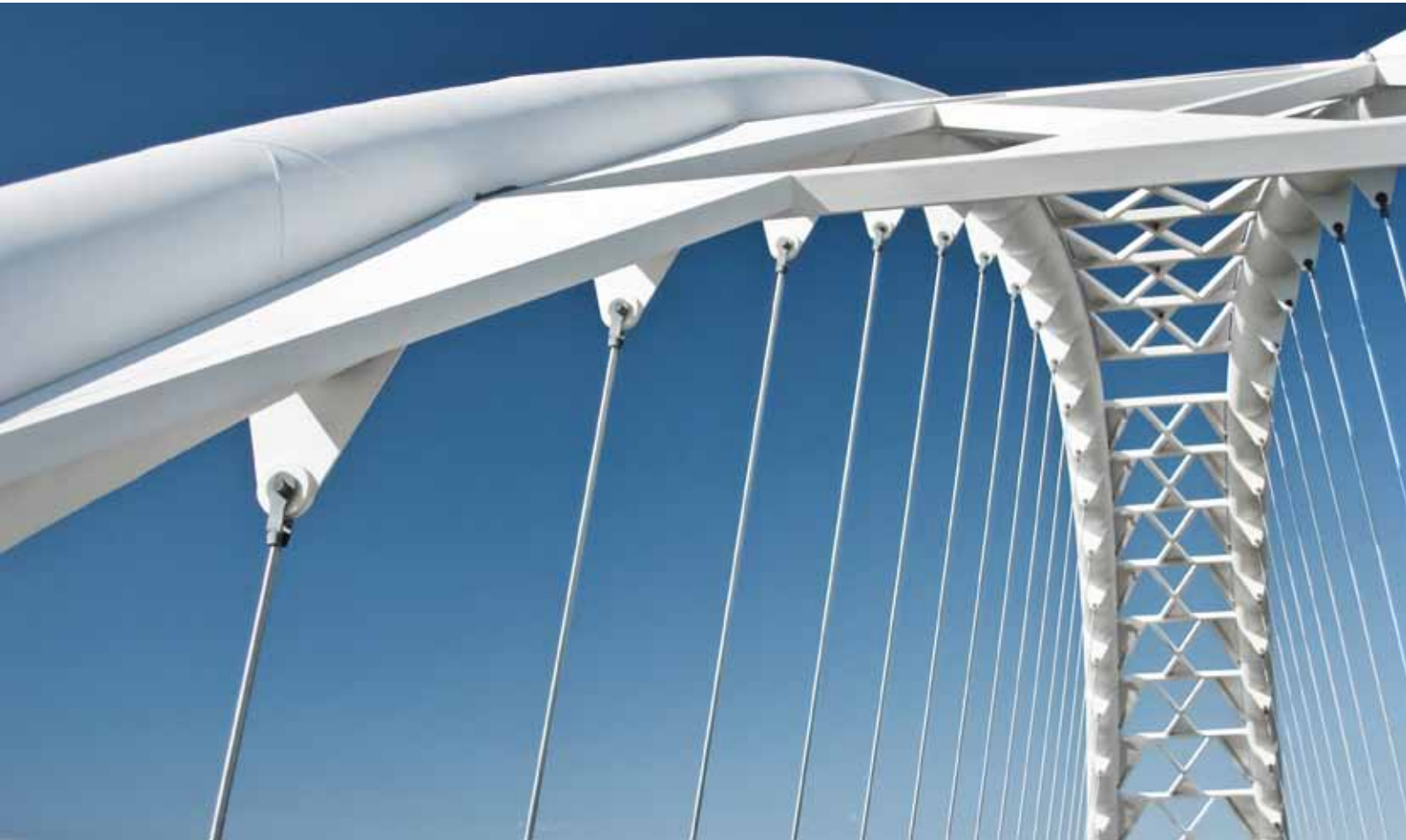
Mit Hilfe des Brückenmonitorings ist es möglich, Schwachstellen einer Brücke genau und ständig zu kontrollieren
