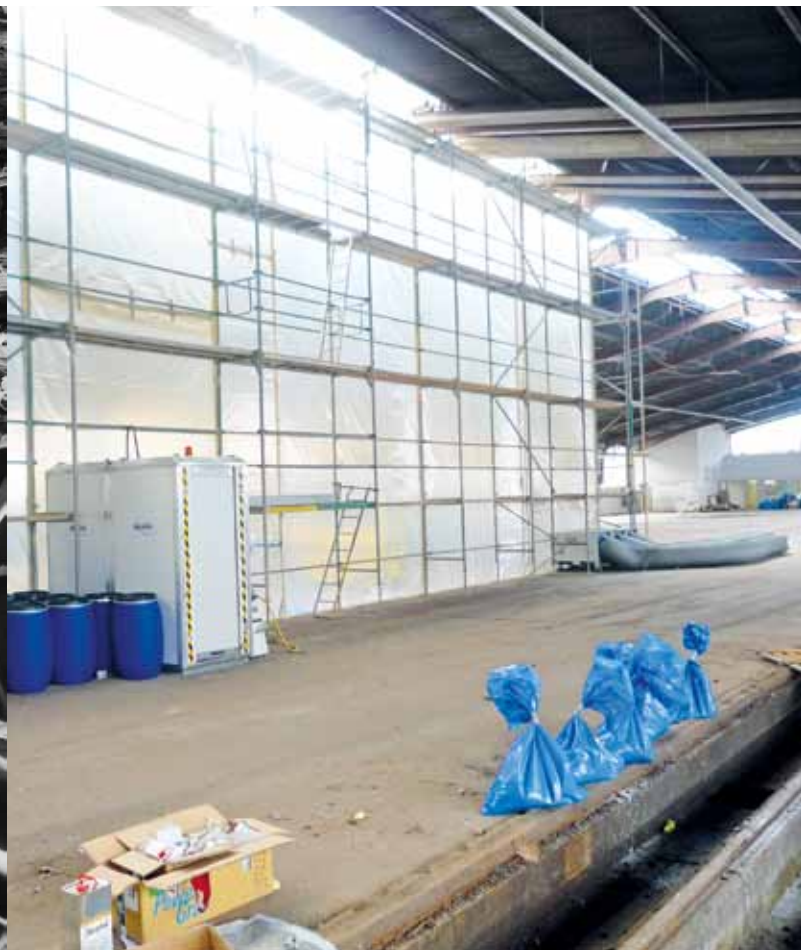
Abgeschotteter Schwarzbereich einer Asbest-Sanierung
