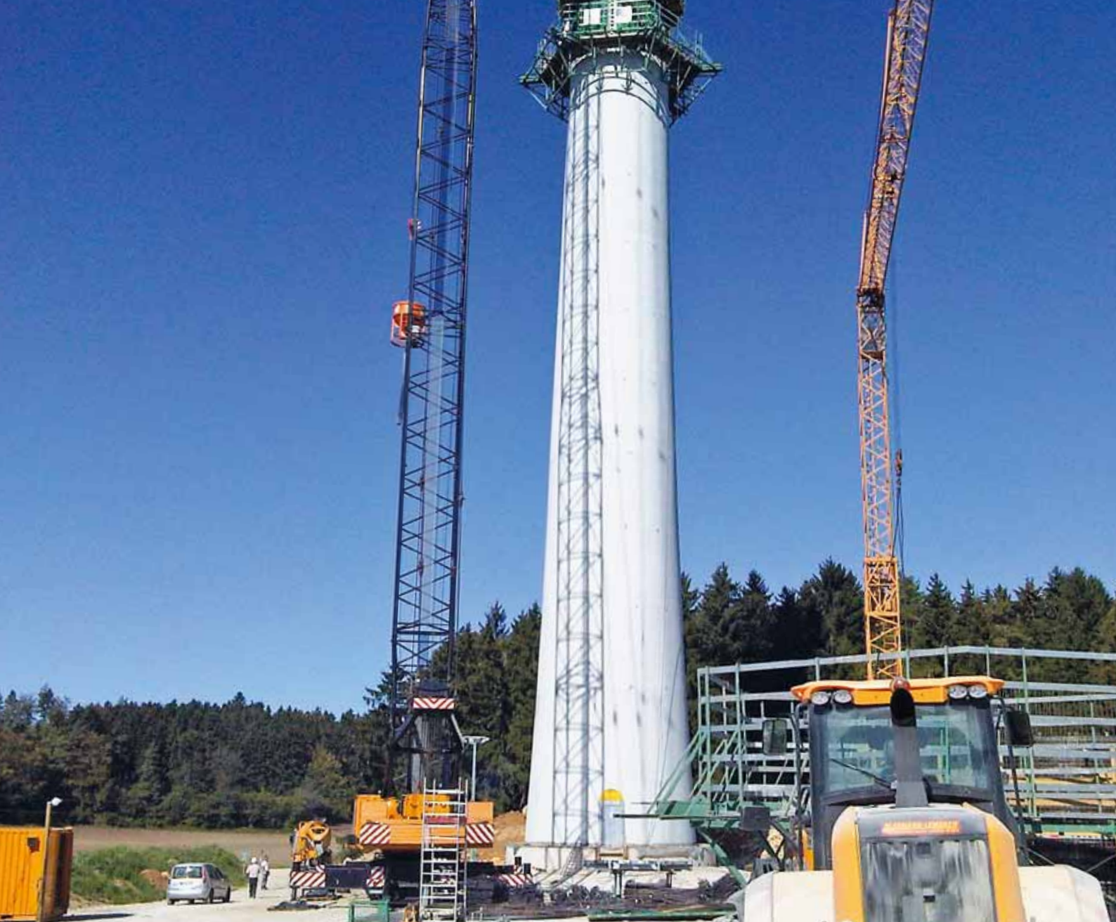
Zukunftsweisend: Bau eines Windrades der Fa. ENERCON an der A9
