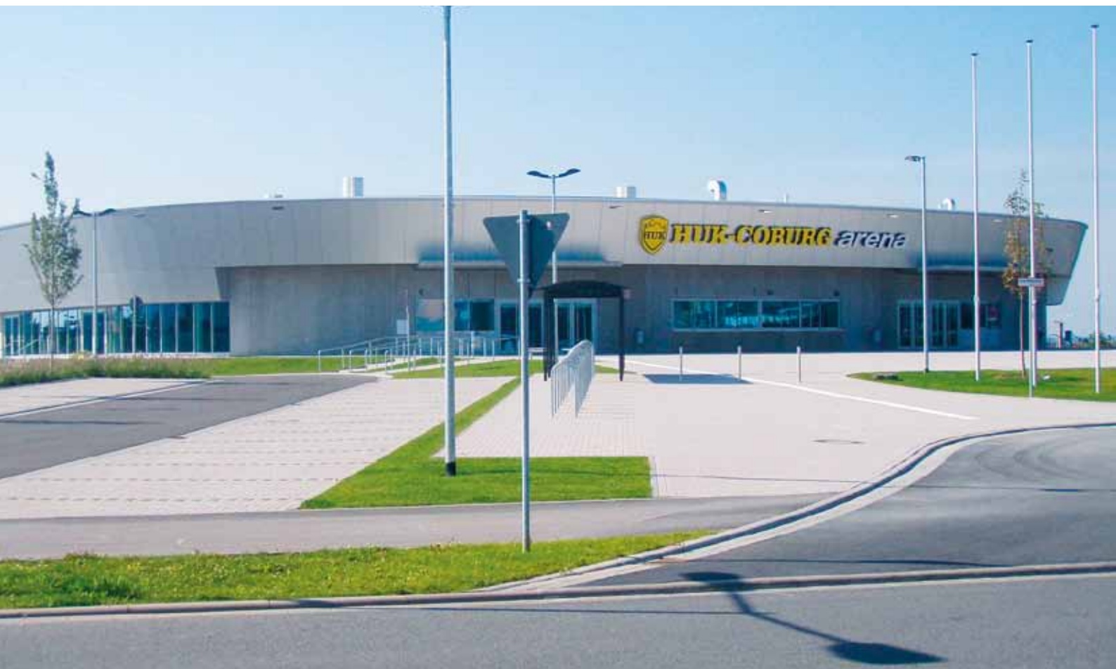
Ein imposantes, fast futuristisches Gebäude und ein echter Blickfang: Die neue HUK-COBURG Arena
