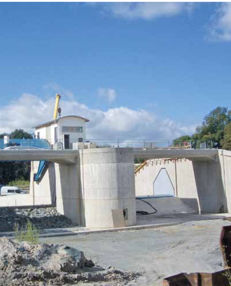
Noch liegt die Wehranlage trocken, der Main wurde umgeleitet
