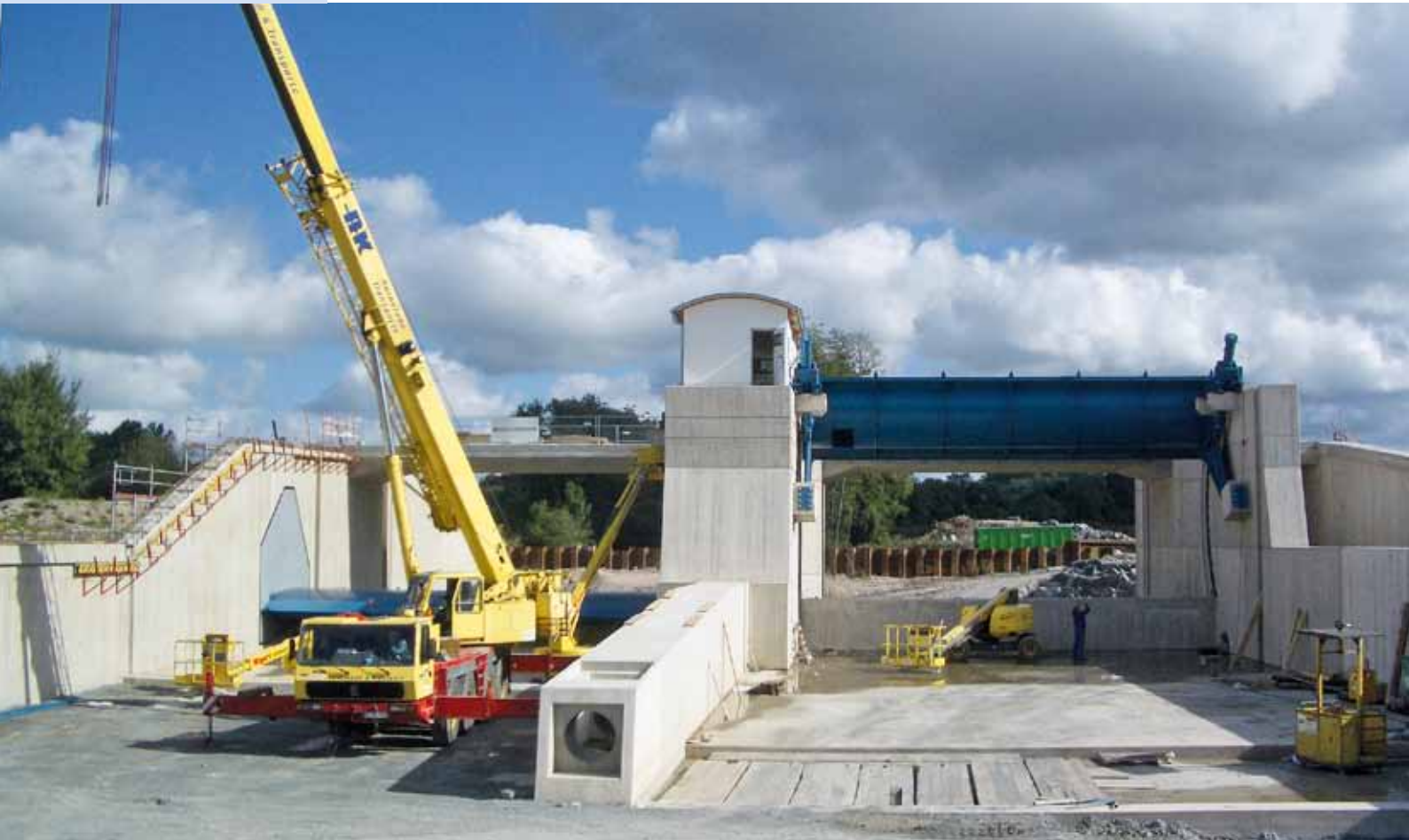
Die Wehranlage besteht aus zwei verschiedenen Wehren, links das Segmentwehr und rechts das Klappenwehr
