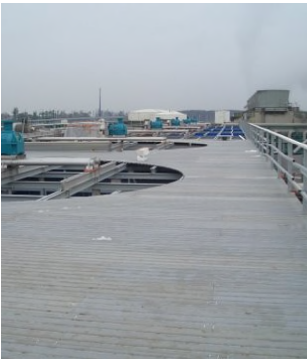
Kühlturmdeck im Bauzustand
