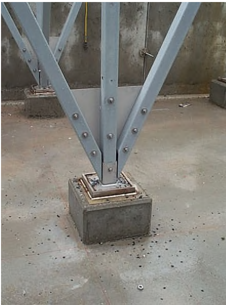
Verbindungs- details des GFK - Tragwerkes
