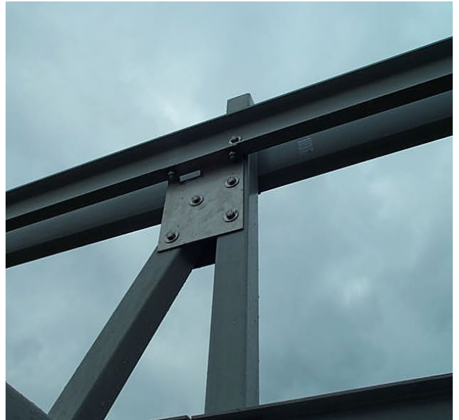
Verbindungs- details des GFK - Tragwerkes
