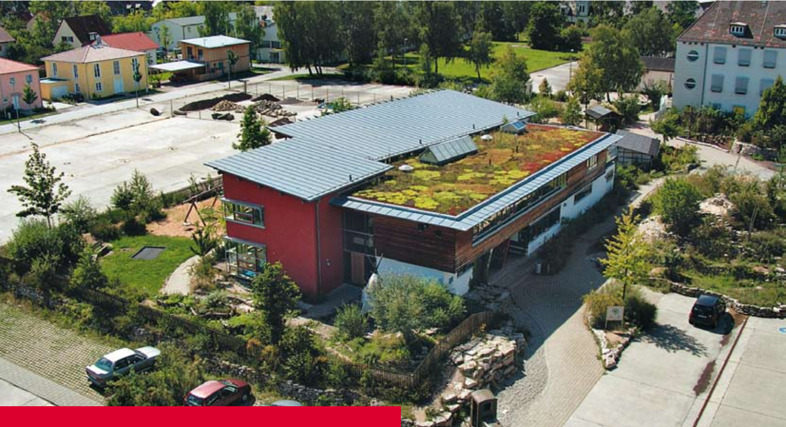
Stadt Schwabach, Sonderpädagogisches Förderzentrum, Kindergarten
