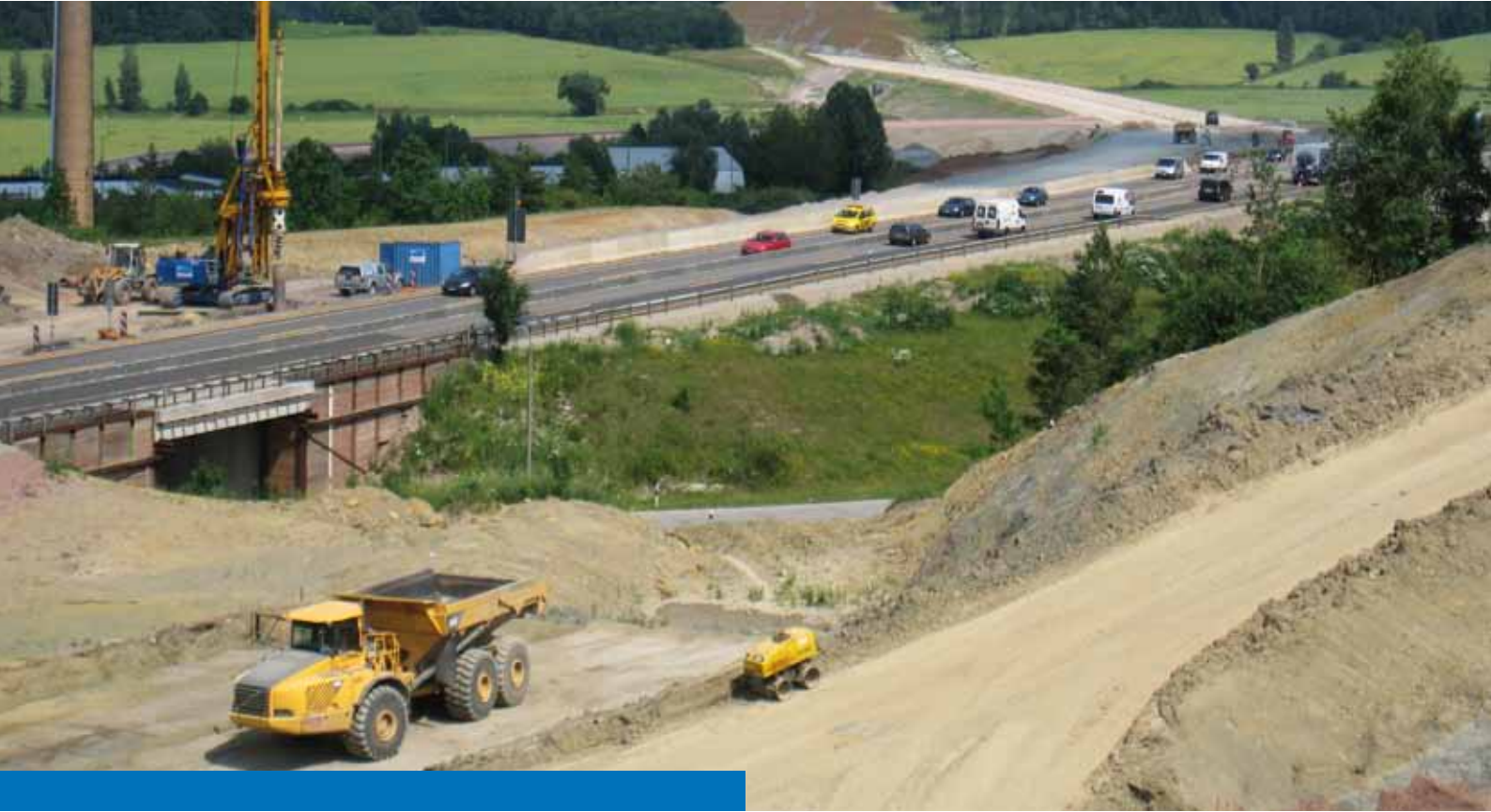
Trasse der BAB A4 H (Hörselbergumfahrung) mit Brückenbauwerk
