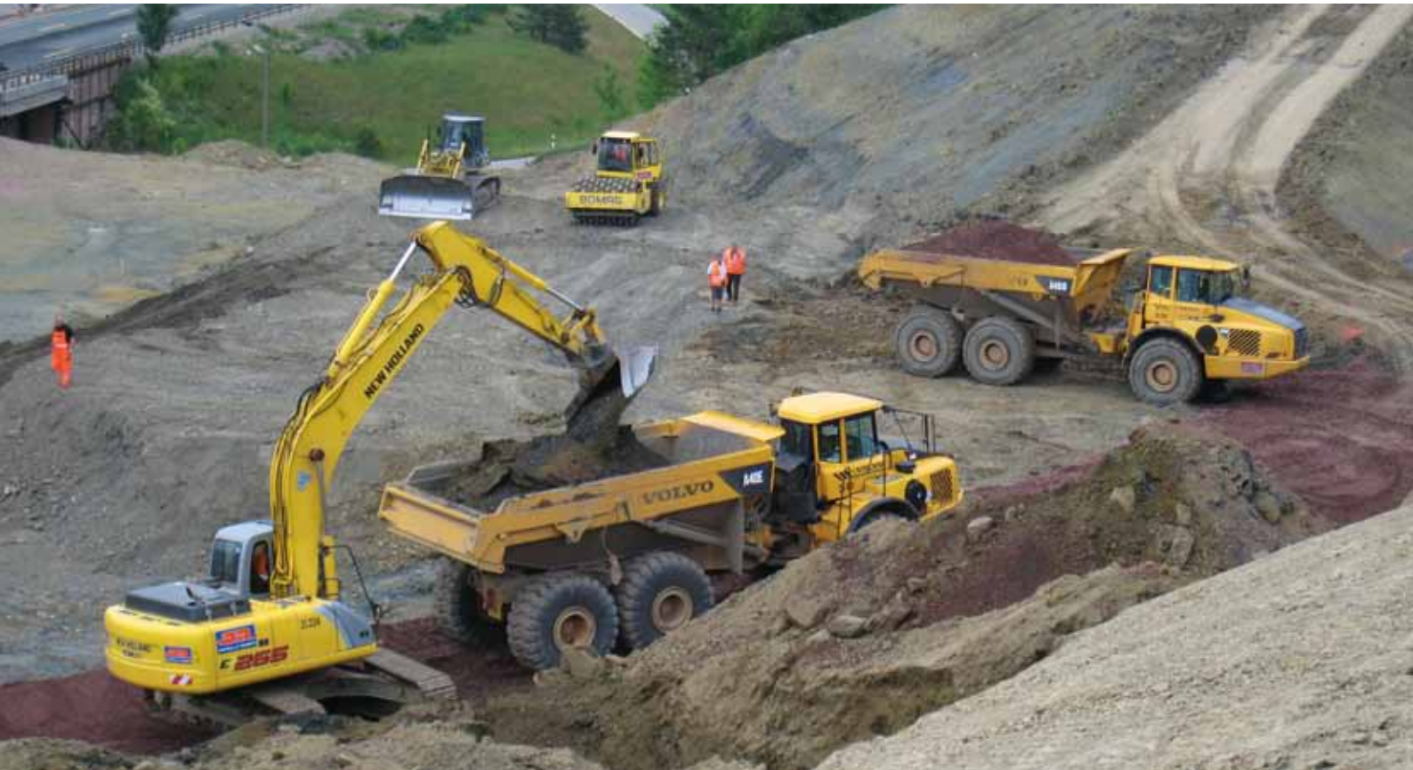
Sanierung eines Böschungsrutsches
