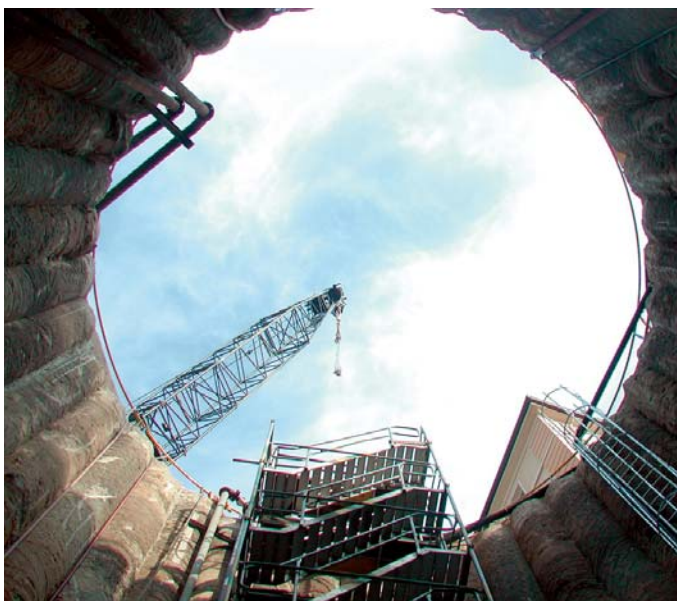
Abb. 15: Bohrfahlbaugrube als Druckring
