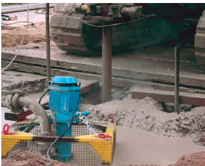
Abb. 12: DSI-Probekörperherstellung mit Reichweitenmessung
