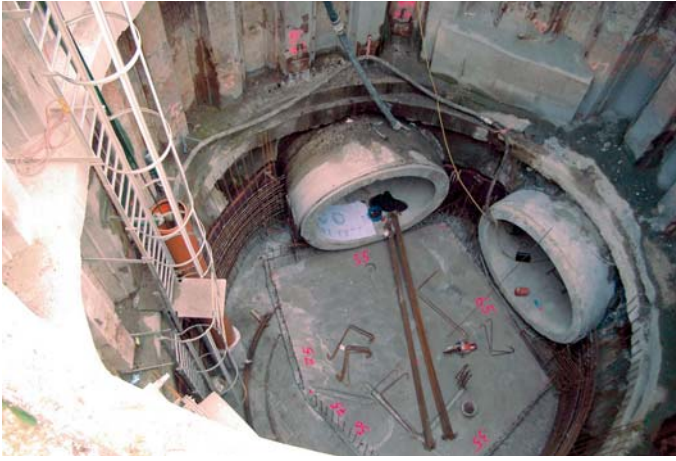
Abb. 5: Kreisförmige Spundwand- baugrube – Aussteifungsringe
