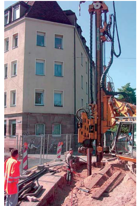
Abb. 2: Spundwandeinbringung
