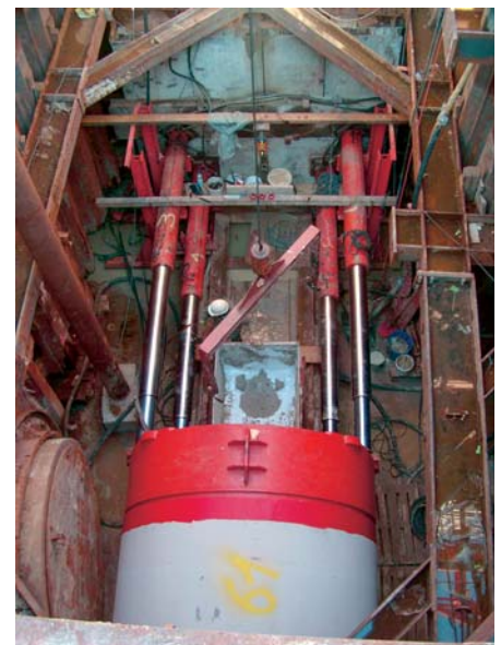
Abb. 4: Eckige Spundwandbaugrube – Aussteifungsrahmen
