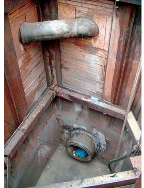
Abb. 6: Spundwand- verbau und Felssicherung – Typ 3
