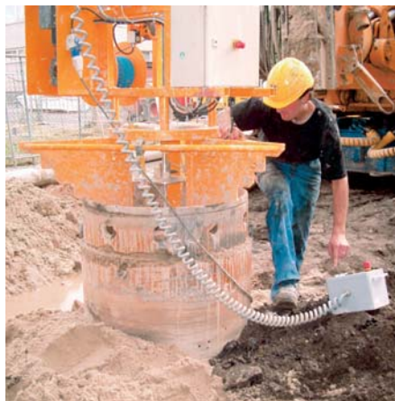
Abb. 10: Bohrpfahlherstellung und Messung der Vertikalität
