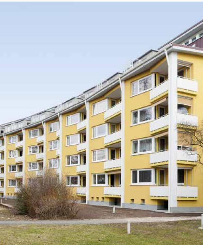
Bernadottestraße in Nürnberg, vorher, nachher
