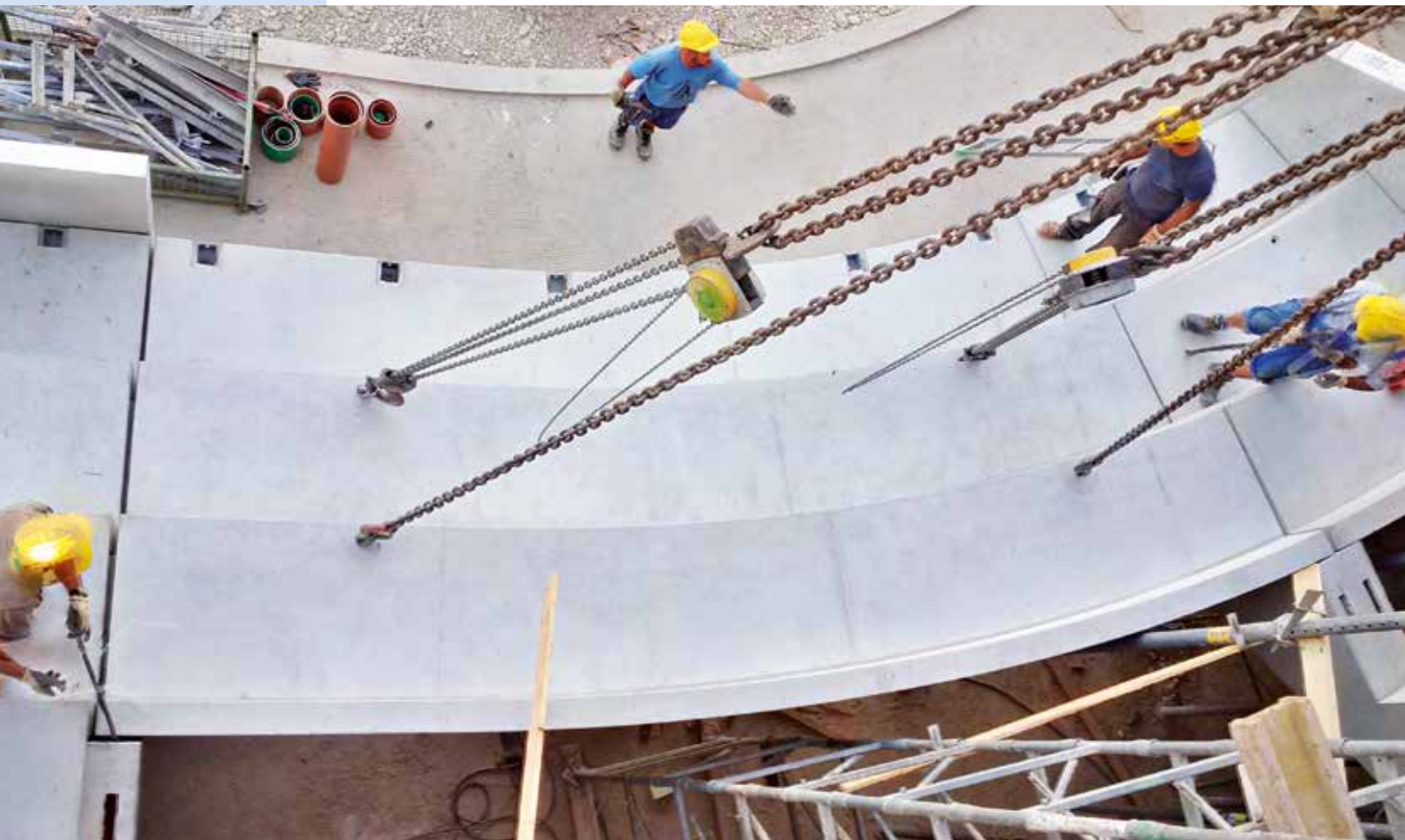
Einfügen der Fertigteile für die Tribünen-Stufen, Baustelle Eisstadion Kaufbeuren.
