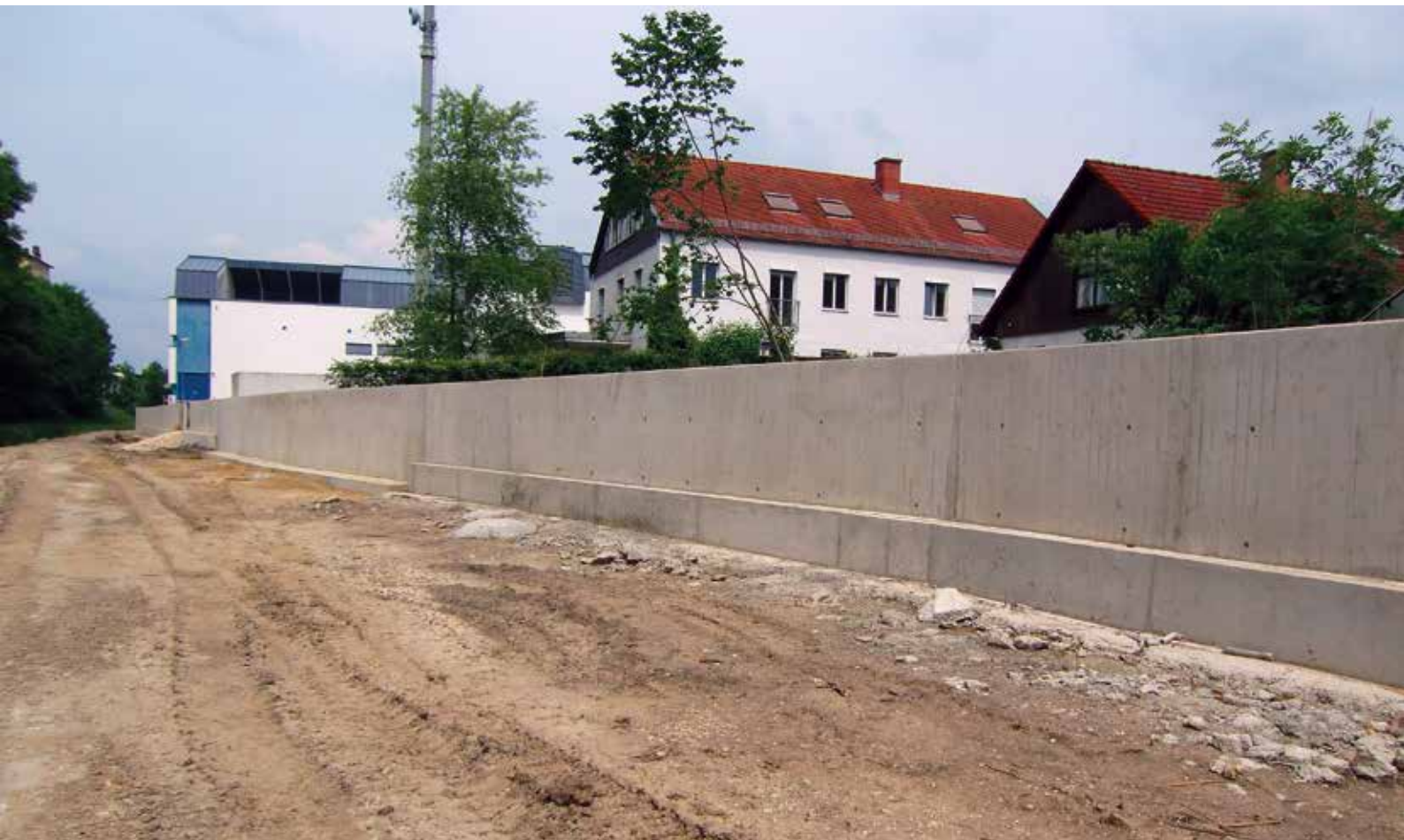
Hochwasserschutzmauer in Aichach
