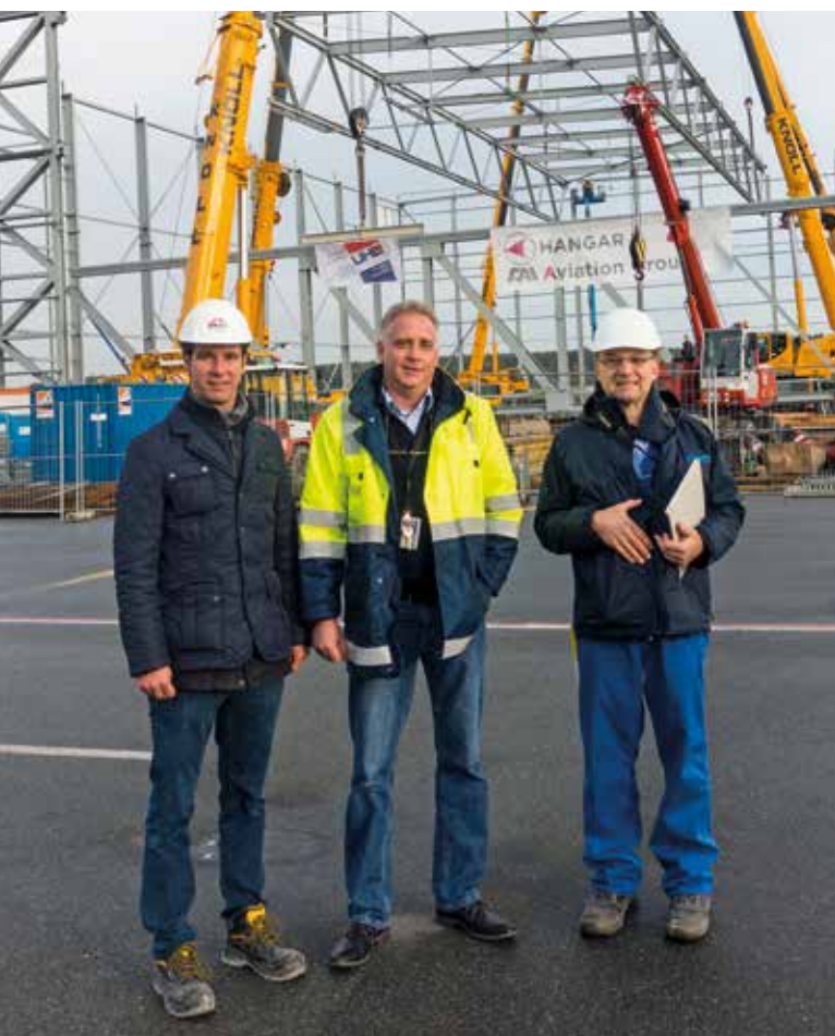
Rascher Baufortschritt beim Hangar 8: Bauunternehmer Jörg Maisel, FAI-Vorstand Martin Mühlmeier und LGA-Diplom Ingenieur Günter Ruck. Foto: Budig
